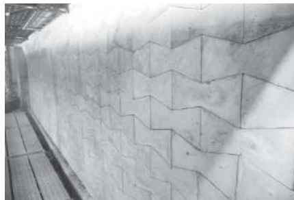
写真1 ESTONEブロック工法による耐震補強壁
