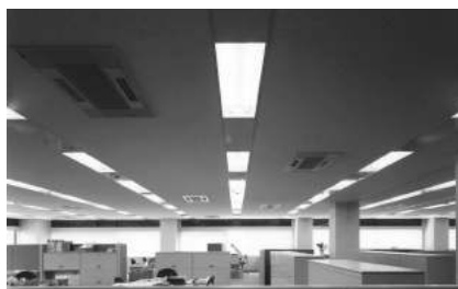
写真1 システム照明天井を採用した事務所
