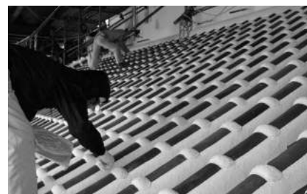
写真4 施工中の屋根目地漆喰
