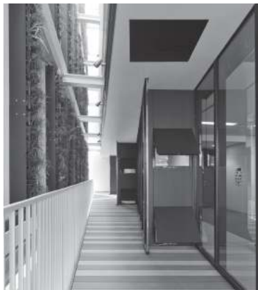
風を正面に迎え室内に導くのがこぎり型換気窓
