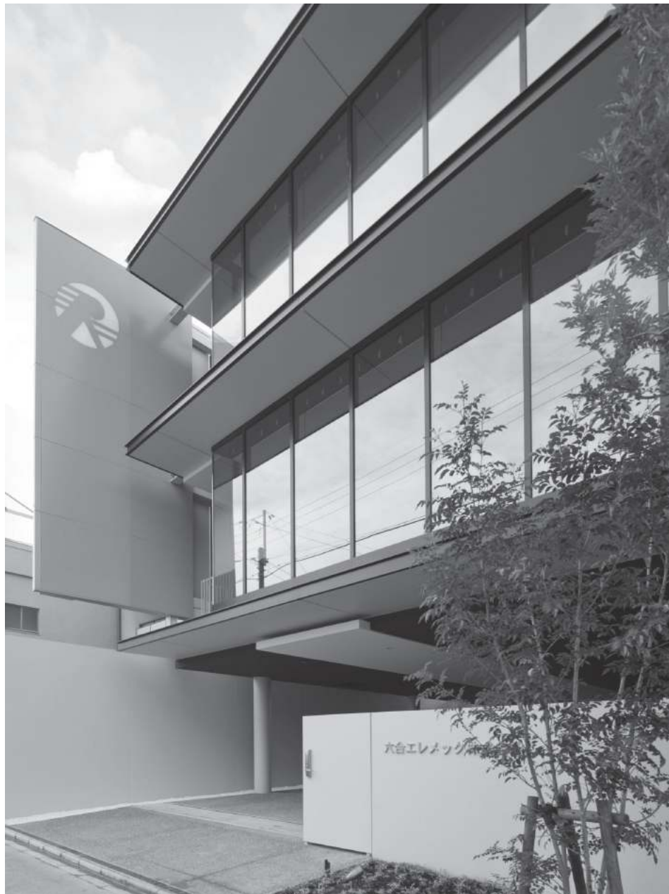
コーポレートカラーの「集風ウォール」が迎えるエントランス
