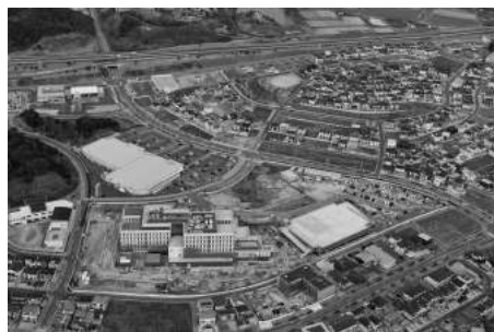
消防署と建設中の新病院 写真提供：SS名古屋
