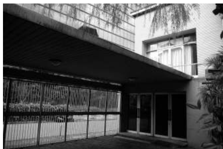
⑨中庭より正面をみる 写真右手が玄関※
