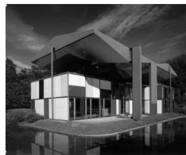
ル・コルビュジエ 《ル・コルビュジエ・センター》 1967竣工 ©FLC
