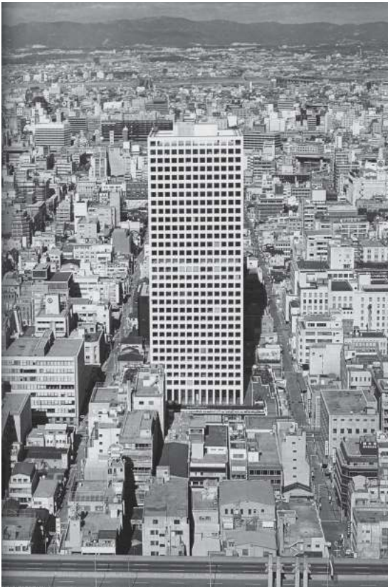
⑧大阪国際ビルディング全景 (航空写真：竹中工務店)
