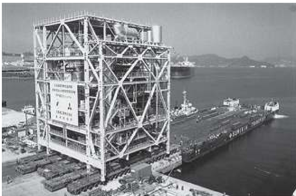
写真4 3,000ton級モジュール
