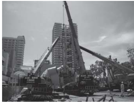
写真9 大型レッカーでの現場設置工事風景
