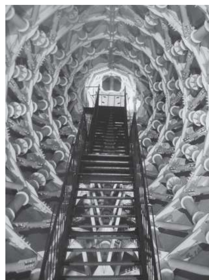
写真2 腕部分内部の鉄骨と非常階段
