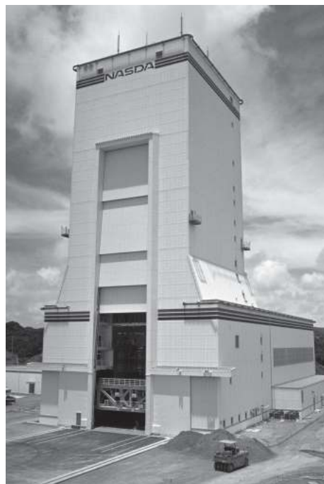
写真2 H-II用VAB. ロケットが通る吊上げ式の扉は幅が狭い。H-IIAではコンテナ開梱、ロケット吊上げに使用されている (写真提供: JAXA)
