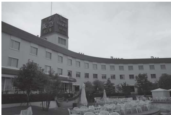
⑫第1期 現状 外観*
