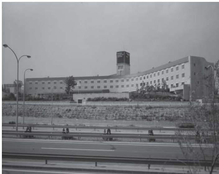
③第1期 竣工写真 外観 所蔵：千里阪急ホテル
