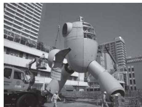
写真4 現地組立公開工事風景。胴体と足の部分がほぼできあがっている
