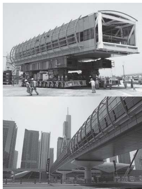
写真5 工事中（写真上）と完成後のドバイメトロのペデストリアンデッキ（動く歩道）
