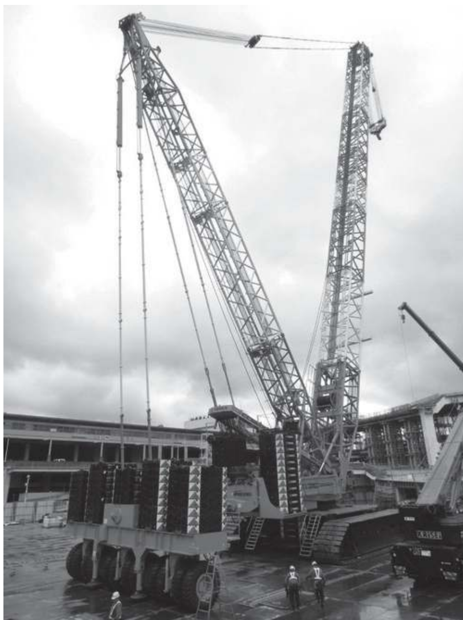
写真7 1,250tonの吊りクローラークレーン
