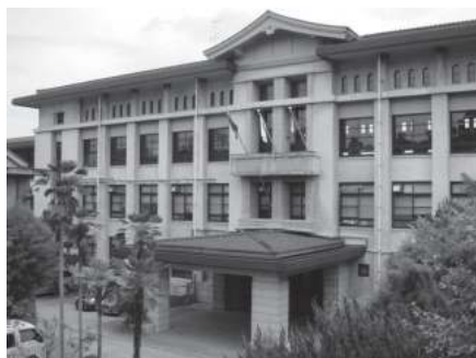
写真 鴨沂高校本館棟
