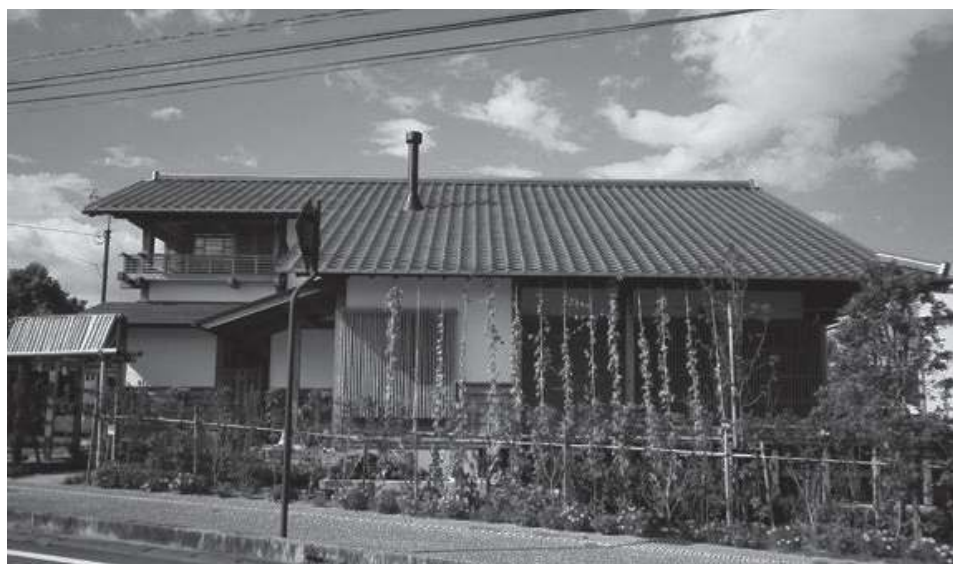
写真1 水俣エコハウス。地元の材と職人によって金物なしの手刻みの木構造、土壁で造られている
