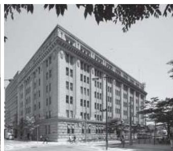
写真3 北西面外観(改修後)
