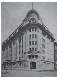
写真1 南西面外観 (大正11年)
