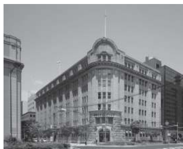
写真2 南西面外観 (改修後)
