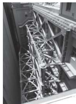
写真4 外付け耐震フレーム
