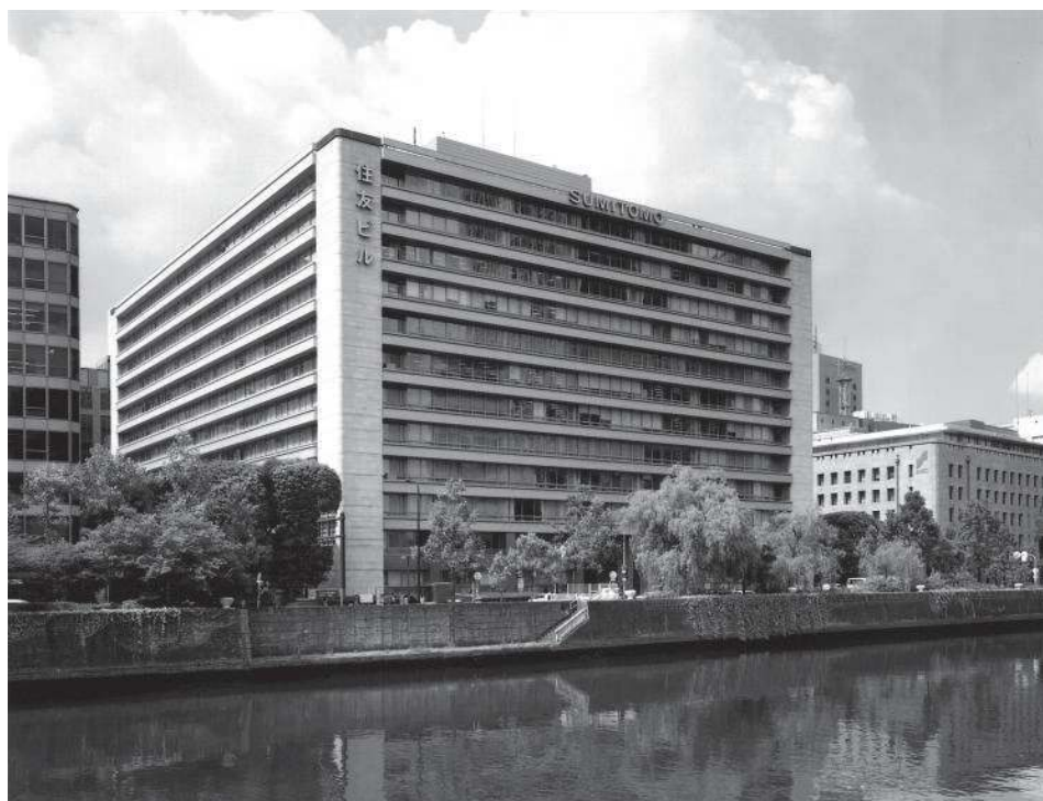
①外観 2012年 提供：日建設計コンストラクション・マネジメント株式会社(以下※印)
