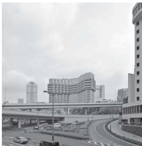
築30年で解体された赤プリ。上から順に2012年12月中旬、13年1月中旬、13年3月下旬に撮影（写真：日経アーキテクチャ）
