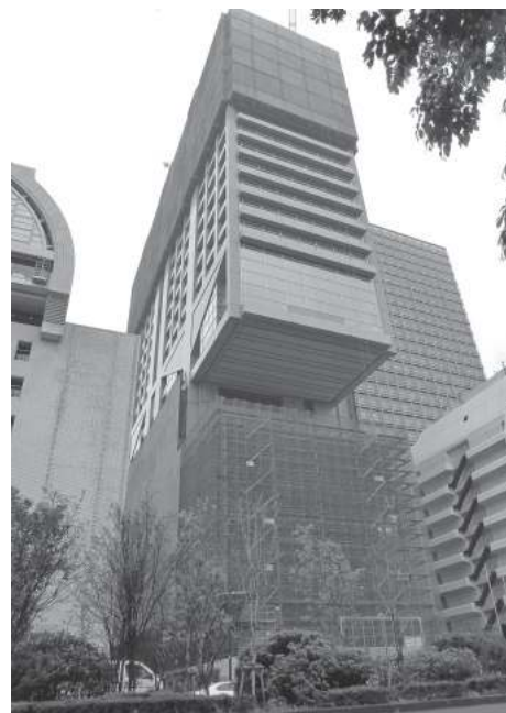
築20年で解体される旧長銀ビル。2014年4月下旬に撮影。設計は日建設計、施工は竹中工務店が手掛け、1993年に完成した。耐用年数は60年を想定していた（写真：日経アーキテクチュア）
