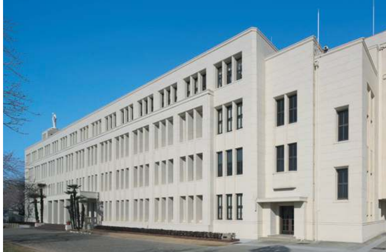
中高棟南側外観：既存外壁に増し打ちされた、既存意匠を尊重した耐震補強構造体
