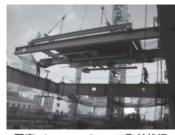
写真-2 ユニットフロア取付状況
