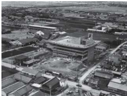
⑮東北側俯瞰（上／外構工事中・南側に旧庁舎 右／1965年頃か・左前に消防署） （東大阪市市史史料室提供）
