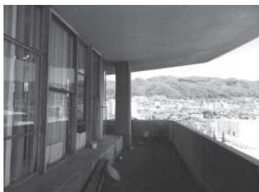
⑲4階南東側（軒天井・バルコニー）（※）
