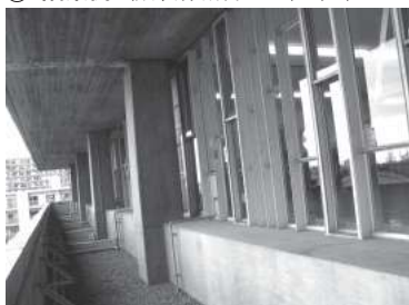
⑲3階東側（バルコニー逆梁構造）（※）
