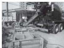
モックアップによるグラウト・コンクリートの充填試験
