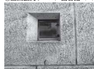
⑲北側外壁研り仕上部（※）
