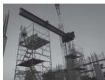
現物での建方試験施工 【写真-1】 試験施工状況
