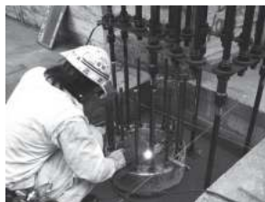
写真2. アンカーボルトの据付
