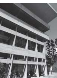
⑲RC造日除け（左上／1階南部見上げ・左／2階東部・右／南東部外観）（※）
