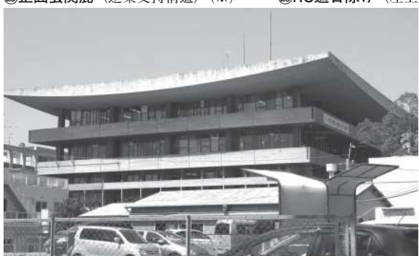
⑲外観 南東（各階律動方立割水平連続窓）（※）
