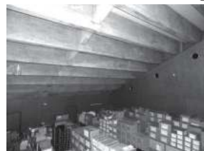
⑱旧議場（左／旧傍聴席階より俯瞰）（※） （内壁／練付板材・RC研り、天井梁／打放し）
