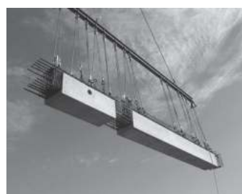
梁PC先行仕込状況
