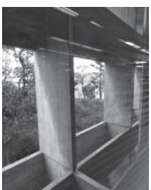
⑲RC造日除け（左上／1階南部見上げ・左／2階東部・右／南東部外観）（※）
