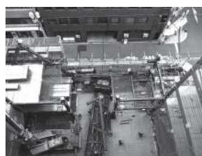
写真3. 鉄骨建方工事状況
