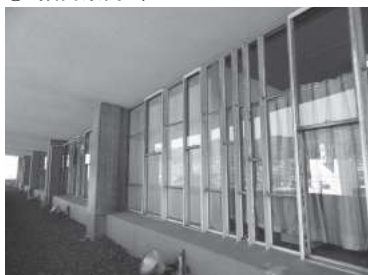
⑲4階東側（鋼製律動方立窓）（※）
