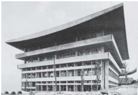
⑩南東側外観（右奥が正面玄関）
