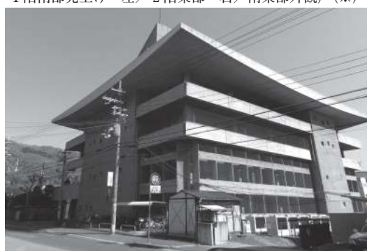
⑲外観 西北（北側1階出入口／西側1階通用口、西面5層）（※）
