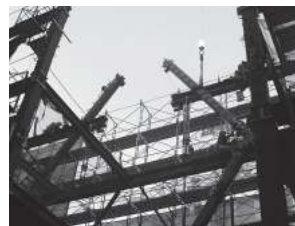
写真4. 斜柱の建方作業状況
