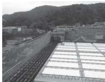
外周垂直ネット養生状況
