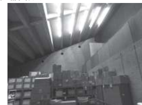
⑱旧議場（左／旧傍聴席階より俯瞰）（※） （内壁／練付板材・RC研り、天井梁／打放し）
