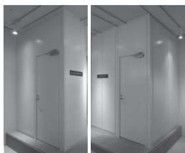
高耐震間仕切G 左がロッキングタイプ 右がスライドタイプ
