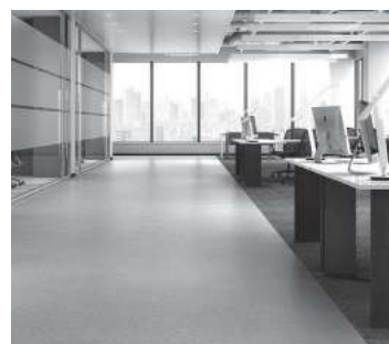
ビニル床材とタイルカーペットの貼りあわせ
