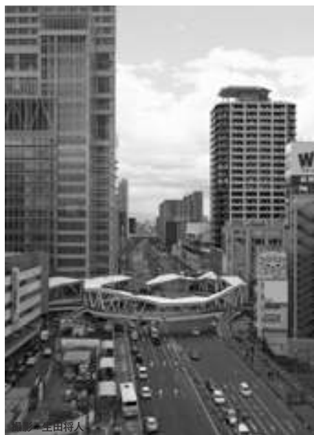
写真4 交差点北側からの景観
