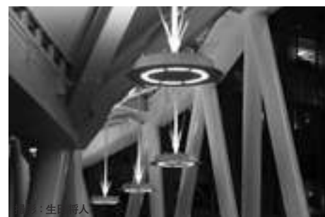
写真5 歩道面と屋根を照らす照明
