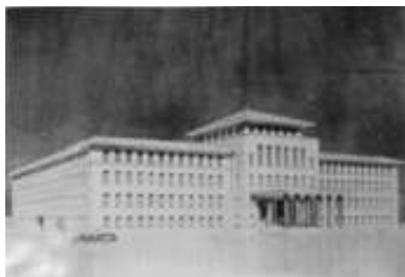
写真19 静岡県庁舎本館外観図
