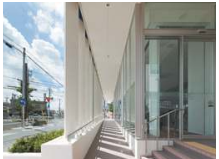
東側スロープ
