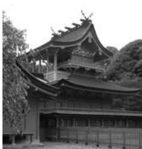
写真1 富士山本宮浅間大社本殿全景
