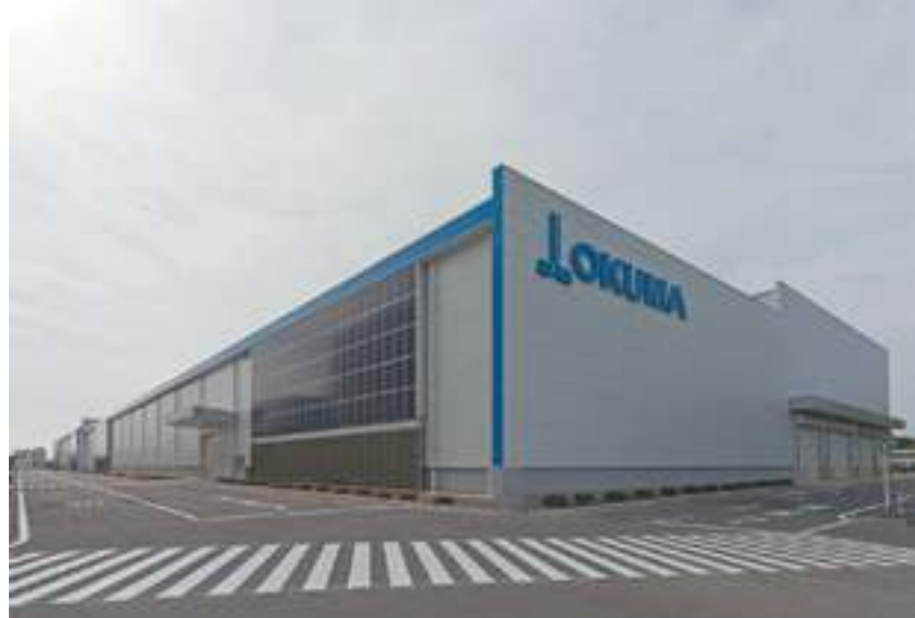
組立工場 南東外観（＊）
