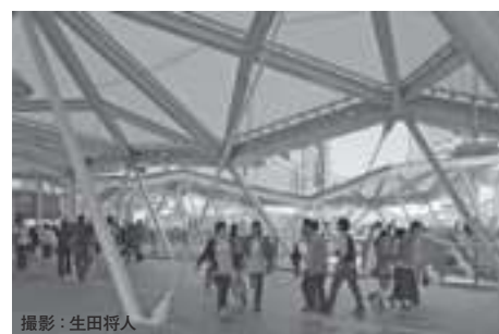
写真2 歩行者でにぎわう歩道橋
