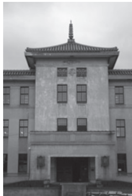
⑯奈良県立畝傍高等学校 北館北面 昭和8年
