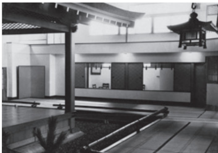
再建された山本能楽堂 昭和25年(1950)
