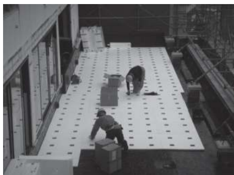
シロマーブロックの施工
