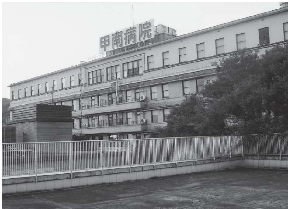
①本館棟外観 本館5階は増築されている／撮影：坂本勝比古（以下※印）
