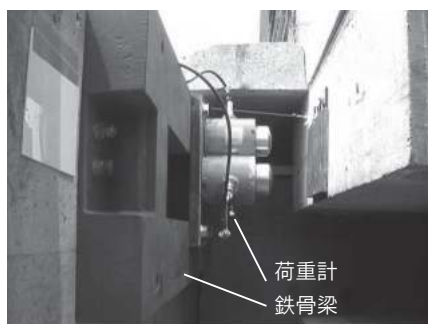
写真2 荷重計および鉄骨梁の取り付け状況
