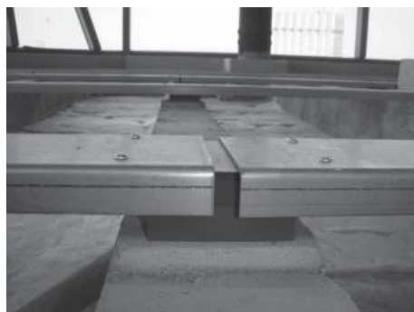
シロディンと大引きを使用した湿式浮床
