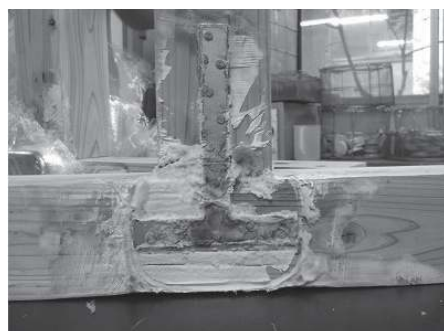
写真6 設置12ヶ月後の接合部の腐朽状況
