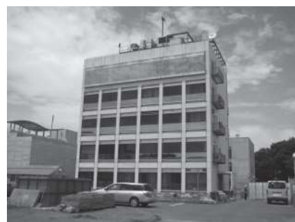
写真1 免震建物外観
