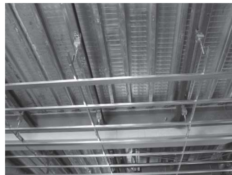
防振遮音天井の施工
