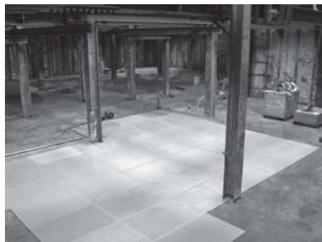
シロマーで全面支持した地中床
