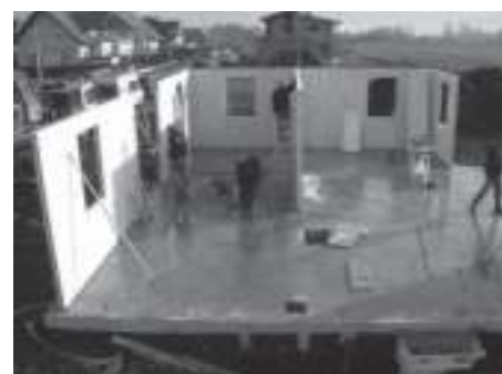
写真4 クロスミナパネルによる建て方（住宅）
