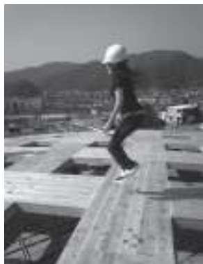
写真9 芦北地域資源活用総合交流促進施設・上棟時の屋根架構
