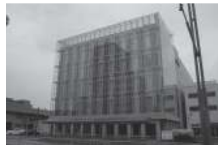
写真1 丸美産業 本社ビル
