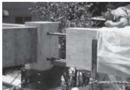
写真2 鉄筋挿入接着工法
