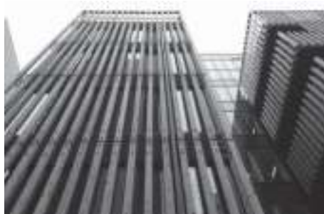
写真3 建物南面見上げ
