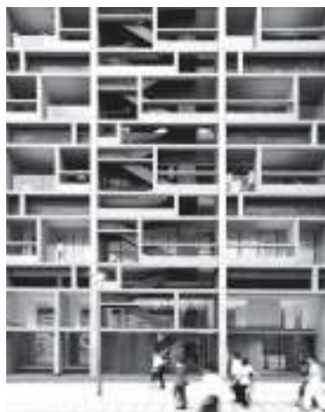
写真7 木材会館・正面ファサード
