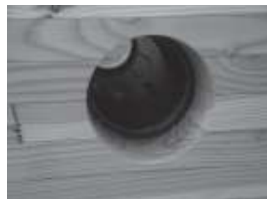
写真5 梁貫通孔 (内径100φ)
