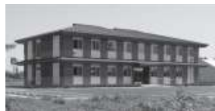
木造庁舎の整備事例 (横浜植物防疫所つくばほ場)
