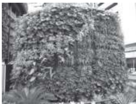
土壌基盤型壁面緑化（排気塔）
