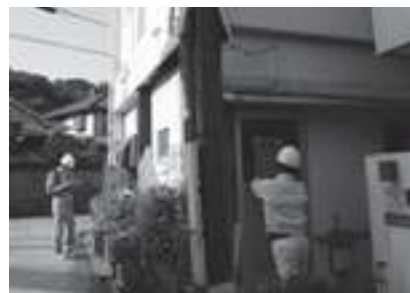
応急危険度判定士による建物調査
