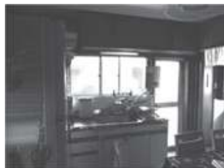
M邸の既存ダイニングキッチン。暗く老朽化している。出入口のサッシは有効600mm。家事の動線は煩雑である
