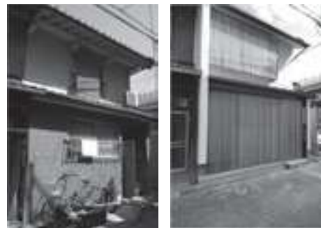
左上写真は、築80年ほどのM邸。阪神大震災で壁に大きな亀裂が生じ、応急処置をしたままになっている。右上写真は改修後。必要な耐力壁を設け、耐震性能を上げた
