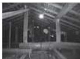
詳細調査の様子。小屋裏では小屋組図作成のための採寸を行いながら、雨漏りの有無、構造の不具合などを確認する
