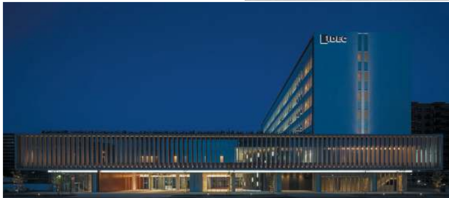
タイムスケジュールで制御したLED照明が映し出す静寂感ある夜景ファサード
