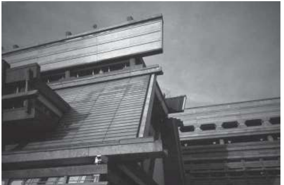
①南側から見る会議室B棟の外観／撮影：松隈 洋(以下*印)
