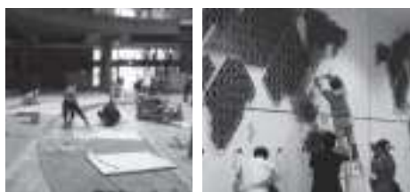
巨大現場は、外装PC版や床の研出しをはじめとし、内装の特殊塗装、サイン、各種演出系の造作にいたるまで、職人の技に支えられた
