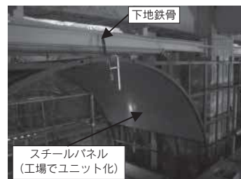
写真3 ユニットパネル取付状況
