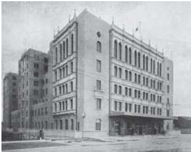
⑫新大阪ホテル（『建築と社会』昭和10年3月号より）
