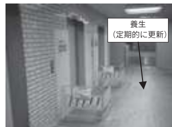
写真4 共用部養生状況
