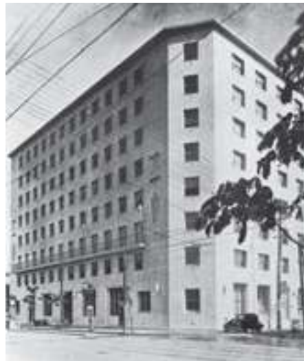
⑬宇治電ビルディング （『建築と社会』昭和12年7月号より）
