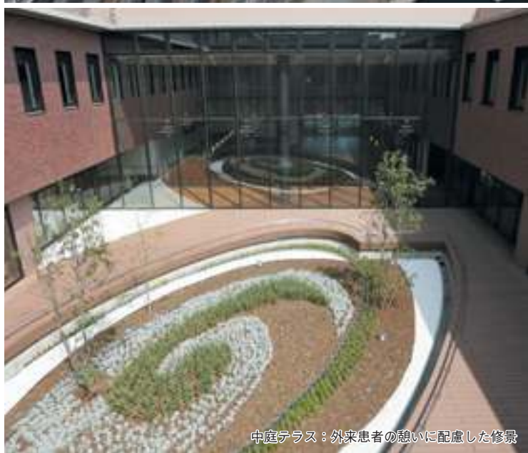
南東側上空から敷地全景を俯瞰
