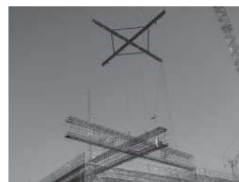
※1 地上で鉄筋を地組して揚重する鉄筋先組工法の例
