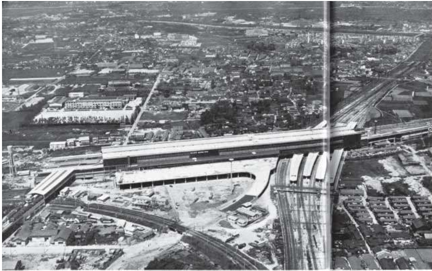
②新大坂駅 竣工当時俯瞰
