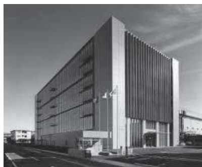
節電インセンティブ空調を導入した、アズビル藤沢テクノセンター第100建物外観
