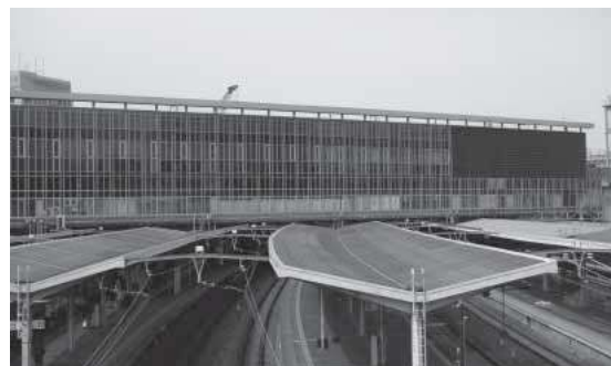
⑪外観現状 (*)
