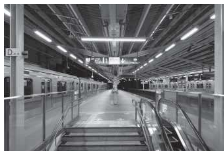
図2 ホーム照明写真(LED化後)
