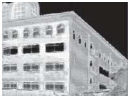
熱画像-1 夏午後5時撮影 左は真西鉛直面の放射温度が高い 右は真南鉛直面放射温度が低い
