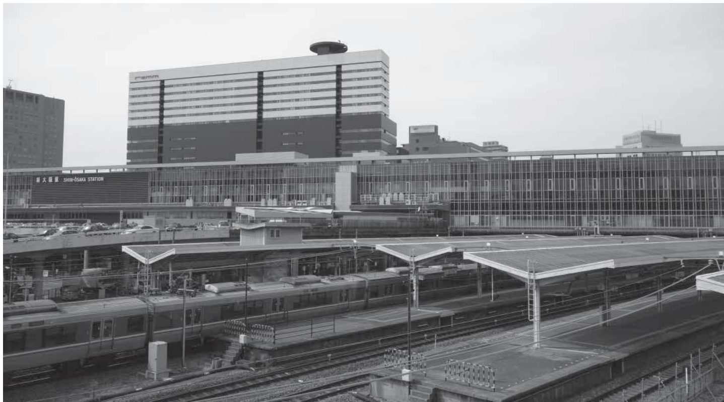
⑧外観現状 (*)
