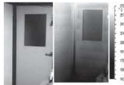
熱画像-3 室内ドア 左可視画像右熱画像 エアコン動作時に壁表面放射温度は上部が高くなる。暖房時期に撮影
