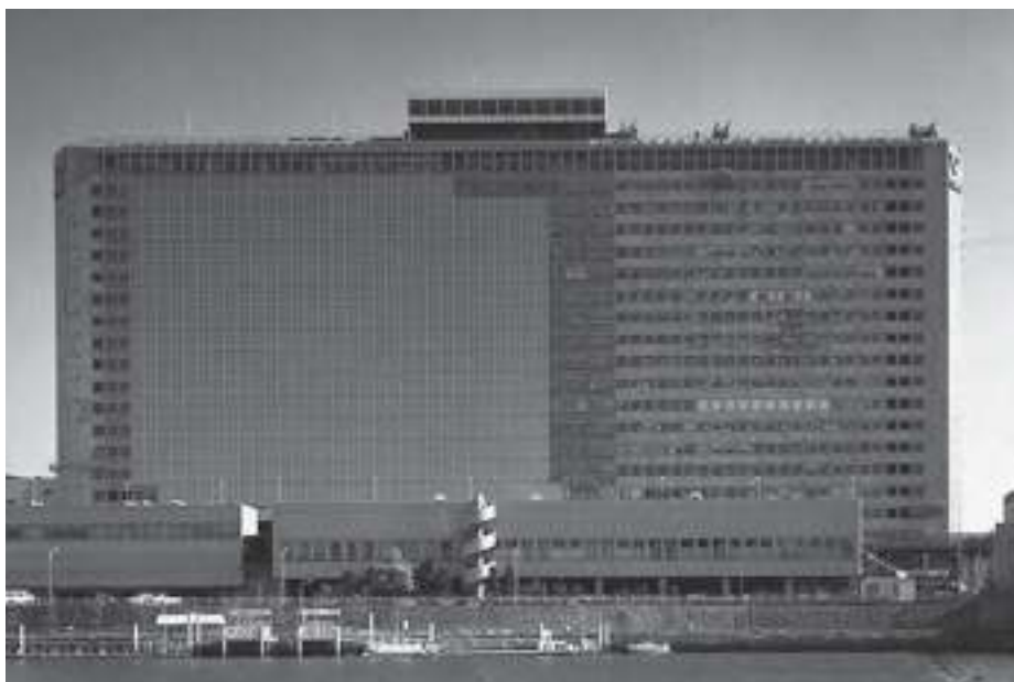
⑨大川越しに見た北側全景（外装工事中）（写真提供：竹中工務店）
