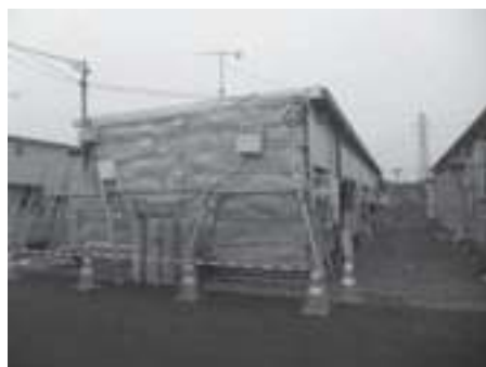
追加工事（断熱工事）
