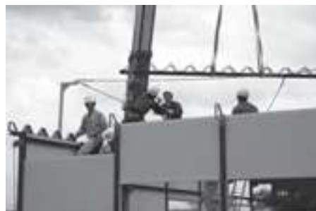
応急仮設住宅建設の様子
