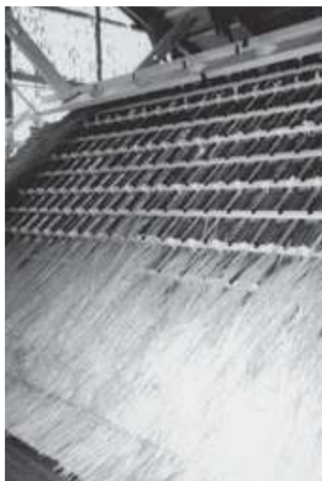
8. 野地板は流れ方向に張った互棒状の野地板の上に萱を葺くが、明治末年以来、野地板の表面に銅板が張られるようになった。
