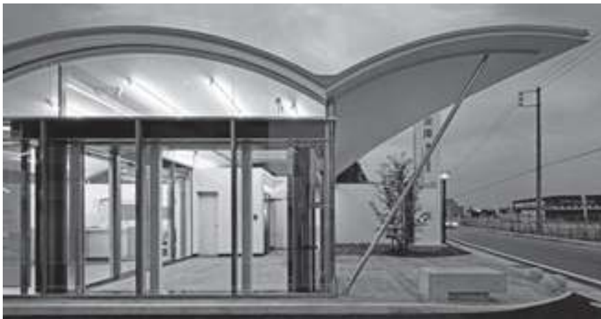
エントランス外観
