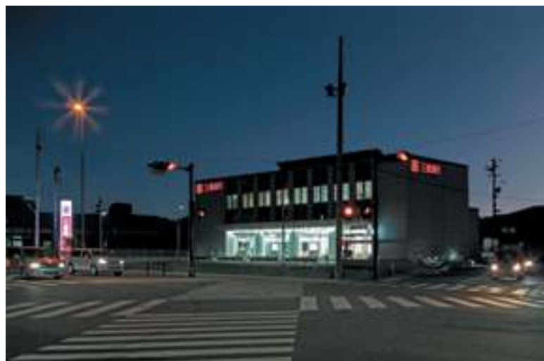
外観 夜景 北西面
