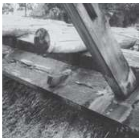
7. 豊受大神宮、外幣殿古殿舎の鰹木・葦覆・障泥板。白木のままで20年間風雨にさらされた部材は朽損が甚だしい。
