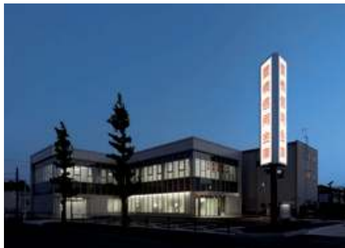
外観 全景（夜景）
