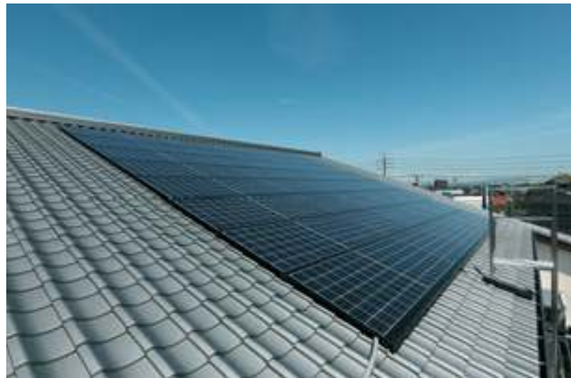
屋根 太陽光発電パネル設置
