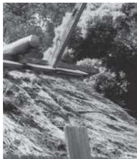
9. 宝殿古殿舎、北側の屋根(平成6年)。20年経過すると特に北側の萱葺は朽損が著しく、鉾竹が露出する。左半分の萱葺は高圧水で表面の朽損した萱を洗い流した状態を示す。残存する萱は機械的強度を保っている。
