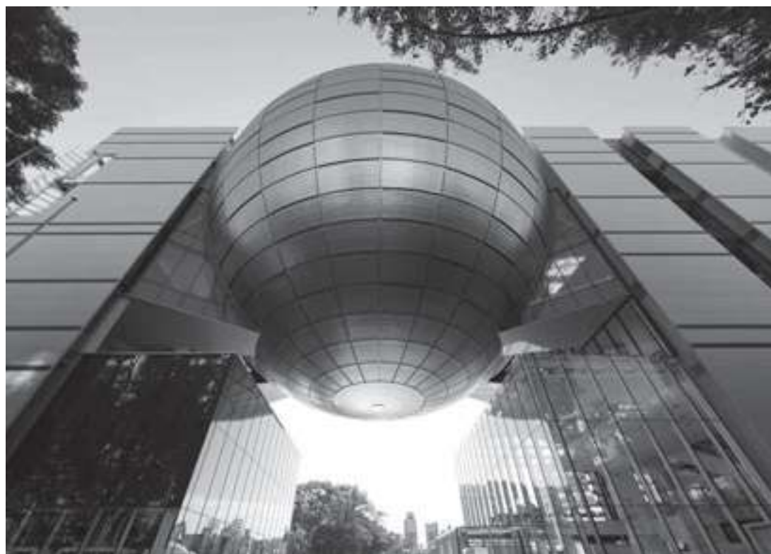
外径約40mの球体を見上げる
