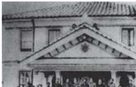
写真4 三重県医学校
