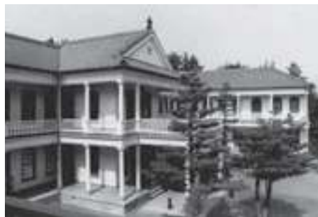
写真5 三重県庁舎（現明治村）
