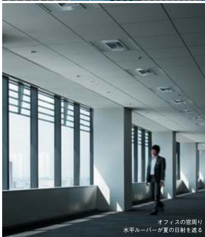
御簾をイメージした 南面の日射遮蔽ルーバー
