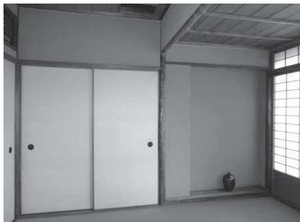
⑭4階和室 平天井と楽天井の組み合わせにより立体的な構成を演出
