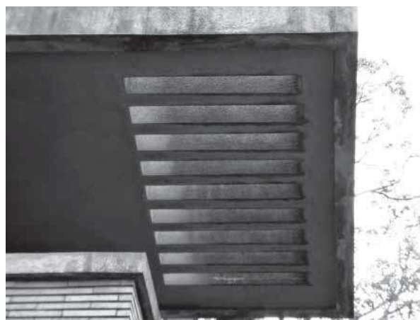
⑪底に開けられたスリット
