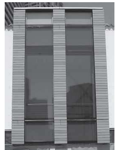
写真2-1 高層棟外装モックアップ
