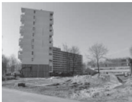
写真3 減築工事中のベルマミーア団地 (2012)
