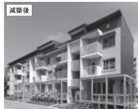
写真6 上部2層減築による住棟再生
