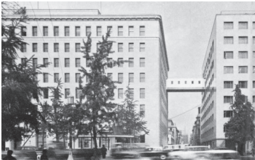
②高架通路を見る
