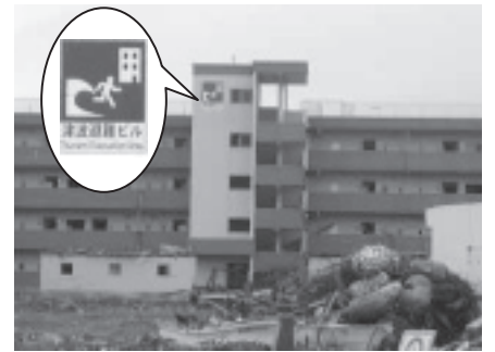
参考：被災した宮城県の津波避難ビル （宮城県南三陸町）
