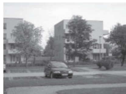
写真2 減築された住棟（ライネフェルデ団地）
