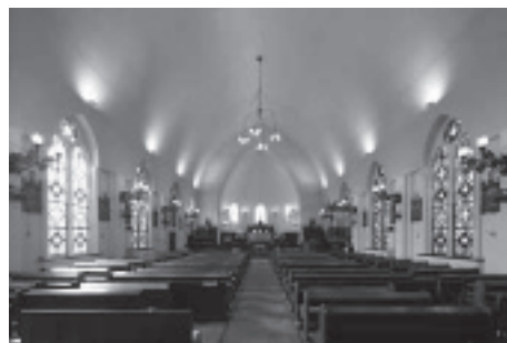
改修後の聖堂1階内観* （柱は約100mm増打されている）
