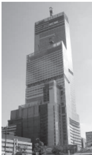
写真-1 工事中の300m超高層建物
