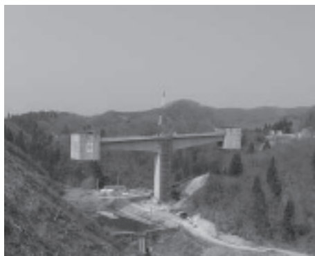
写真3 カンチレバー工法で施工中の橋
