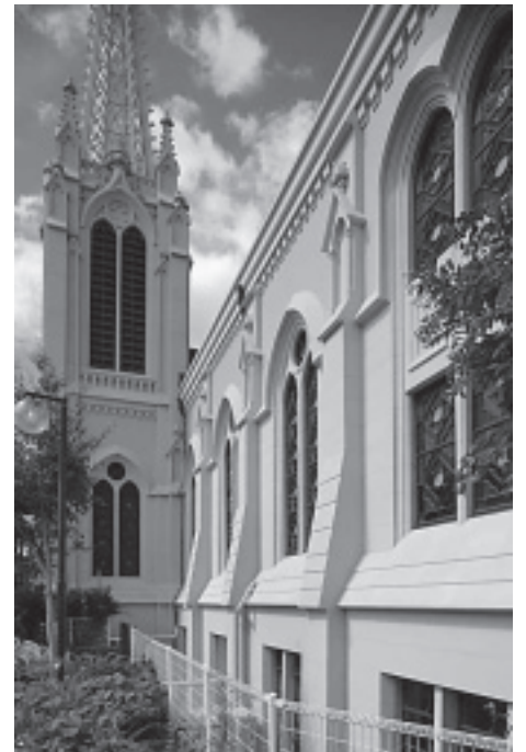
改修後の南側外観* (柱部を補強している)
