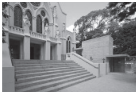
新設したエレベーター棟*
