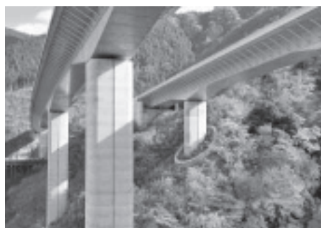
写真2 新東名 芝川高架橋
