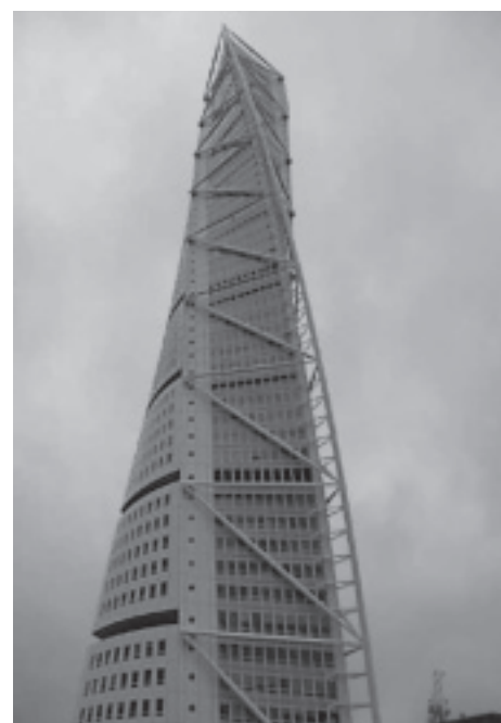
写真-2 カラトラバ設計の超高層建物
