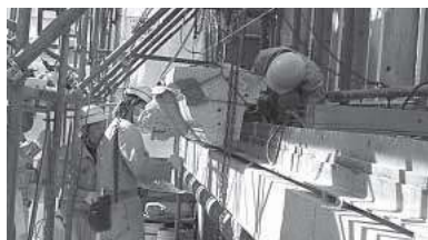
7階大コーニス部分の装飾付の石材取付け作業
