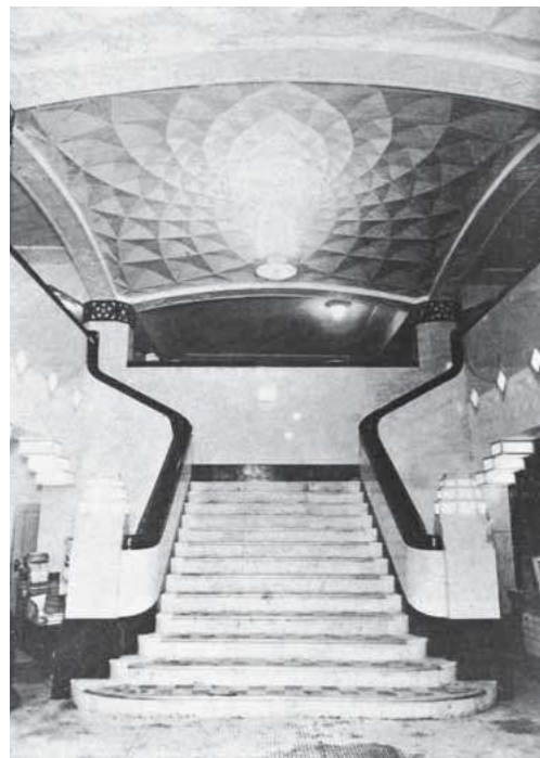
③地下2階階段廻り
