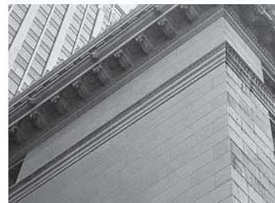
コーナーの左側が試験洗浄壁面、右側は既存の状態
