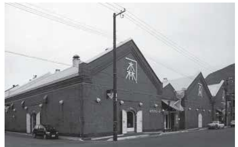
写真3 金森ヒストリープラザ外観
