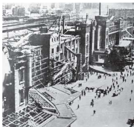
写真2 戦災による被災状況
