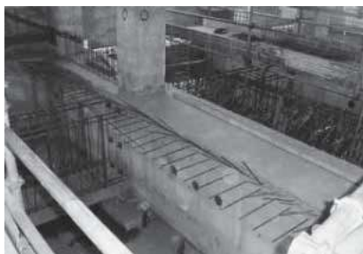
地中梁の補強
