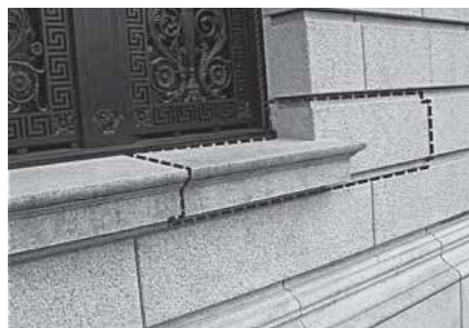
窓台石材、破線で囲われた部分が一つの塊
