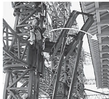
写真4 素屋根鉄骨の取付け
