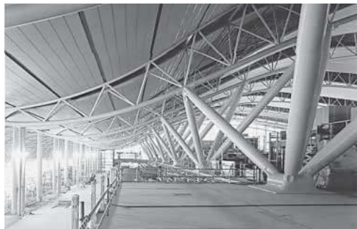
写真3 〈関西新空港ターミナルビル（柱カバー）1994年〉
