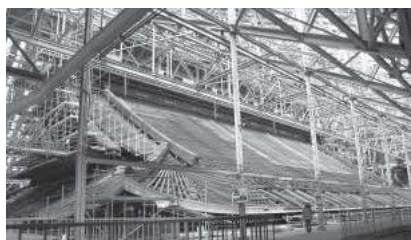
写真5 素屋根内部: 自然採光・自然換気を充実させた
