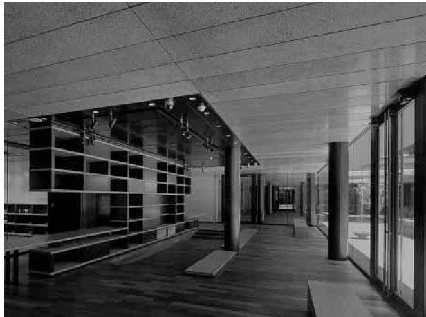
軒天井：石粒混入着色モルタル仕上げGRCパネル
