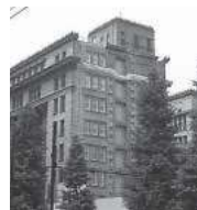
新館撤去後の壁面
