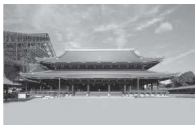
写真1 竣工時正面：左側の阿弥陀堂に素屋根をスライドし転用した
