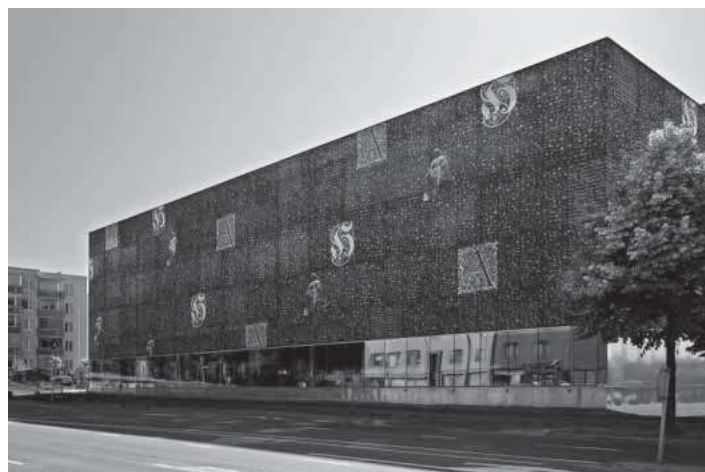
写真11 〈グラフィックコンクリート仕上げ〉
