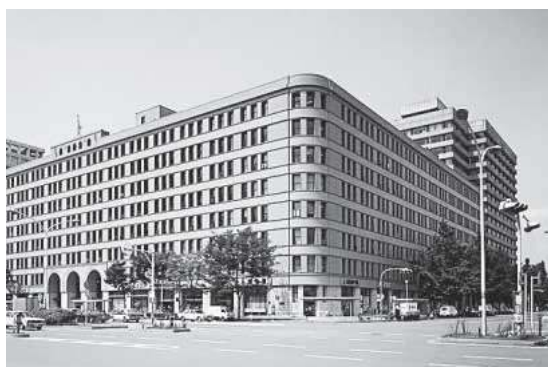
写真1 〈旧丸の内ビルディング（外壁改修）1981年〉
