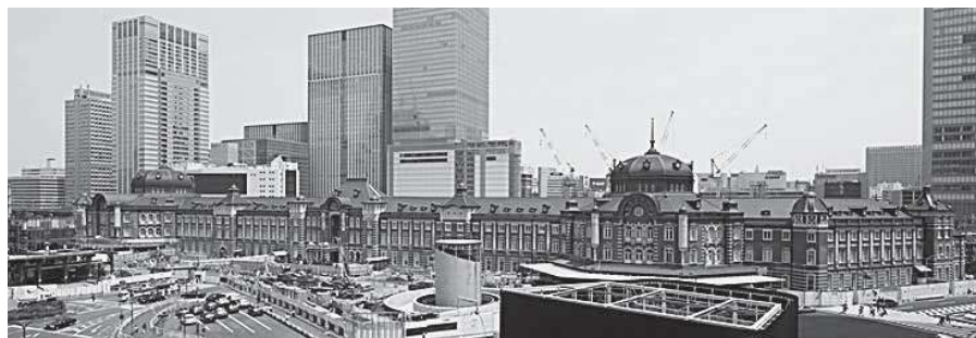
写真7 駅舎全景(平成24年8月末時点)
