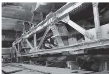
写真2 鉄骨で補強した木造大梁：200年後には容易に取り外せる構造
