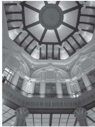
写真5 ドーム見上げ（復原後）
