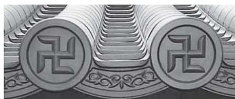
写真5 チタン製段付き本瓦
