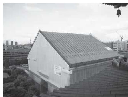
写真2 素屋根仮設状況
