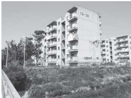
空き家が多い府営住宅
