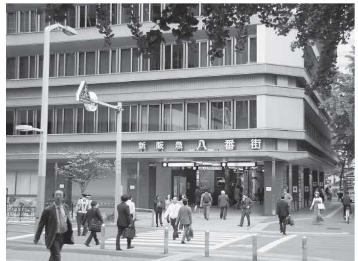
⑭御堂筋側南角部 幅4mのアーケードにはさまざまな方向へ向かう人々が行き交う。
