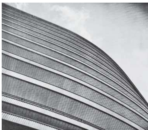
⑦沿道より底を見上げる
