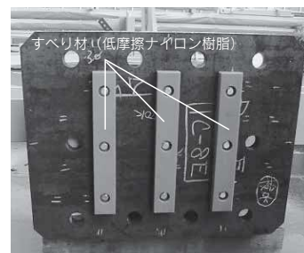
写真-5 柱脚裏すべり材敷設状況
