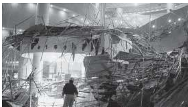
写真2 シネコンの天井落下
