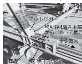
写真-2 柱脚部の詳細
