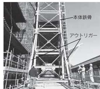
写真-4 アウトリガー設置状況
