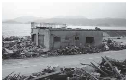
コンクリートの1階部分が残った自宅
