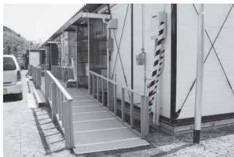
高齢者向けにスロープを設置した仮設住宅（宮城県女川町）
