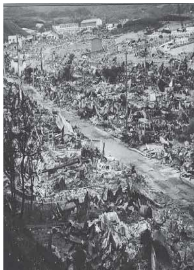
北海道南西沖地震の津波火災の被害
