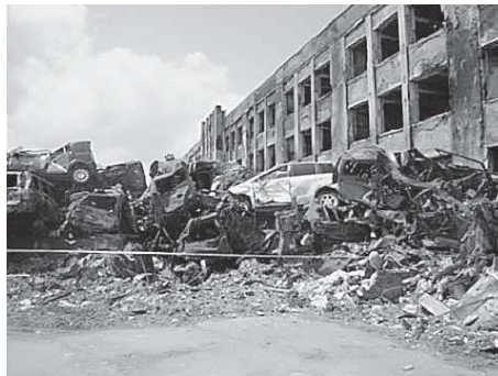
門脇小学校の瓦礫撤去前
