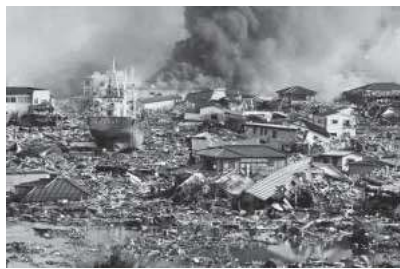
震災直後の釜石市市街地
