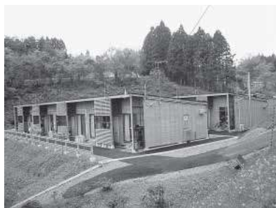
町が直接建設した応急仮設住宅
