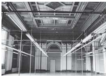
老朽化し執務室に改修された室内
