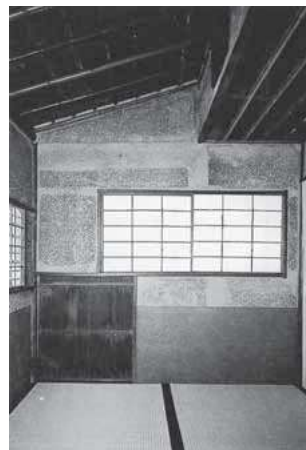
待庵蹴口の壁面を見る 田畑みなお撮影
