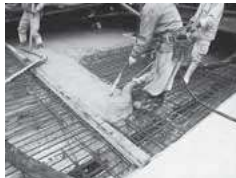
コンクリート打設状況
