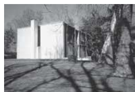
「エシェリック邸」 1961年、暖炉の煙 突が自立して建つ
