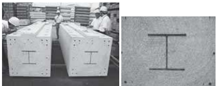
写真2 SRC柱部材充填状況
