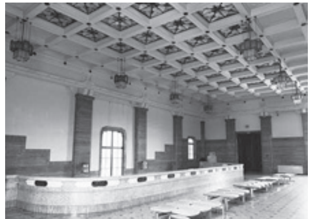
⑱西 2 階ホール 撮影：京都市文化財保護課 格天井で、格間にステンドグラスがはめ込まれている。
