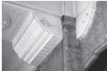
⑬西玄関持送り（＊） 柱側面に接合している。
