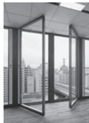
写真2 ダブルスキン：メンテナンス時のインナーガラスが開く
