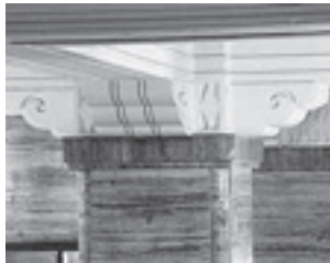
⑫西玄関ホール持送り（＊） 柱上部に乗っている。
