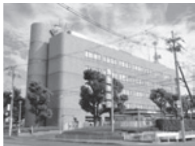
大阪ガス北部事業所外観
