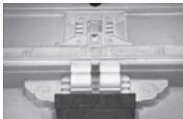
⑮西 2 階ホール持送り（＊） 手前に木鼻状の部材が 2 本突き出る。
