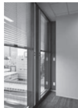
写真1 奥行き260mmのダブルスキン：インナー側はLow-eペアガラス。ガラス面横に縦型換気ガラリを設置
