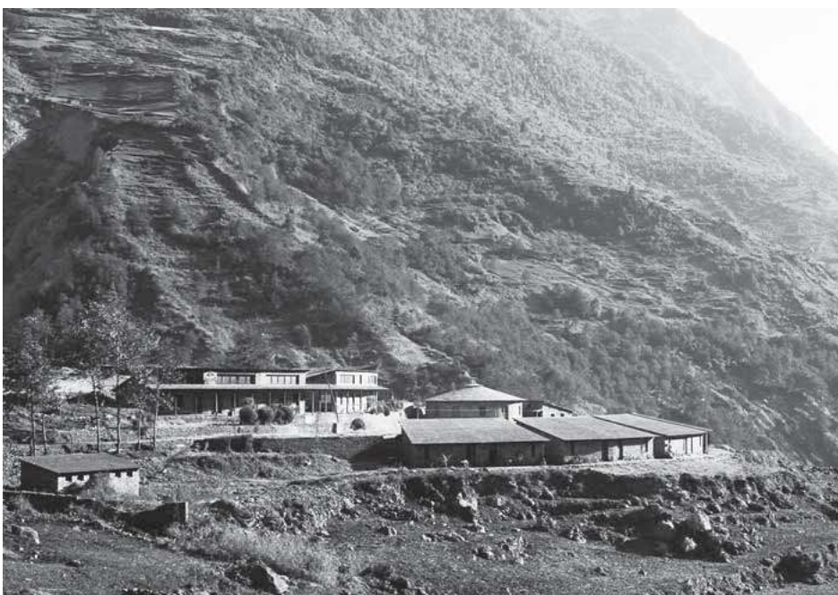
2期工事まで完了したキャンパス全景 (撮影：畑拓)
