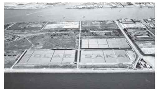
堺太陽光発電所
