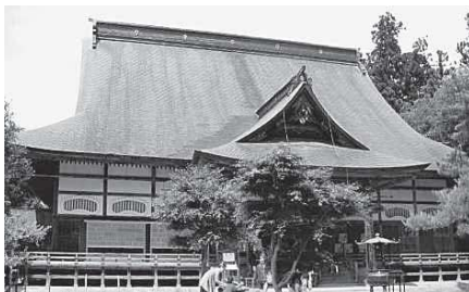
写真1 中尊寺本堂外観
