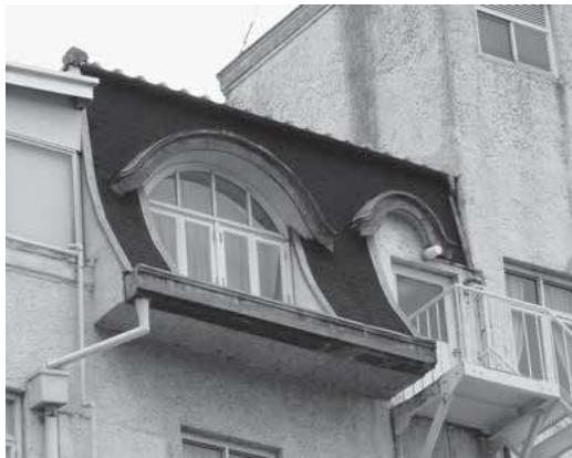
⑨最上階・マンサード屋根
