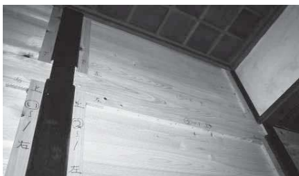
写真2 板壁取り付け状況
