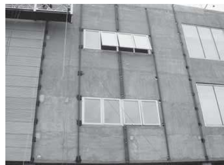
(写真1) RC壁にアングル下地を流し(縦)アスロックを取り付けている。左端は「施工済アスロック」(ゴンドラ下)
