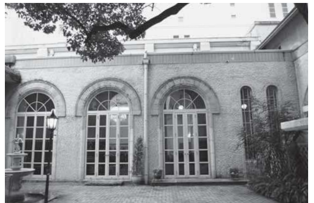
⑬バルコニーの半円アーチの開口
