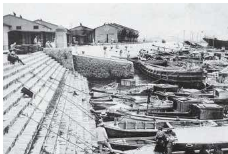
大正13年当時の名古屋港2号地護岸 （名古屋港管理組合蔵）
