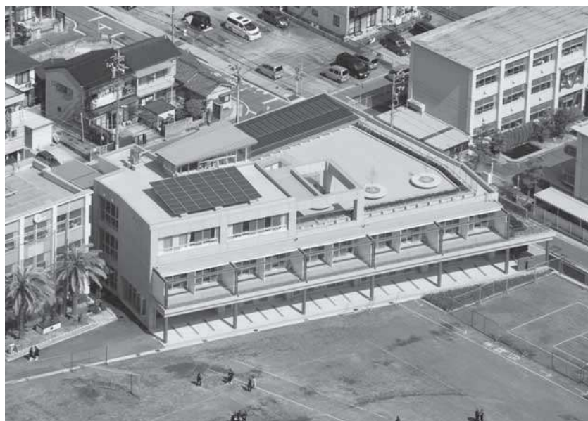
増築校舎全景
