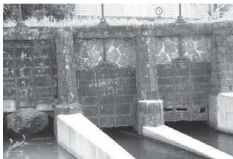
人造石の牟呂用水第5樋管
