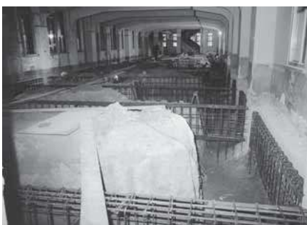
⑯地中梁（平成7年保存改修）
