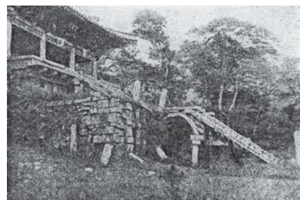
図3 修理前の仏国寺（明治初期） 岩波書店『朝鮮の建築と芸術』より
