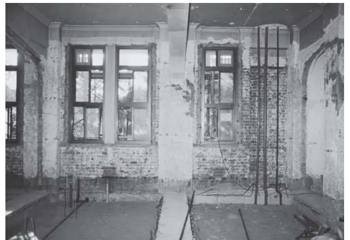
⑮煉瓦で仕上げられた壁体（平成7年保存改修）
