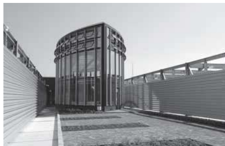
屋上階で自然採光と換気を行うエコボイド
