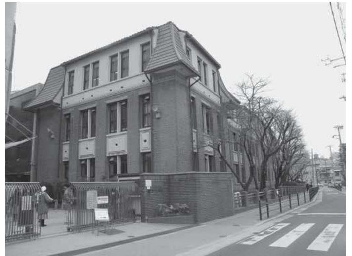
⑬東側のマンサード風寄棟屋根現状
