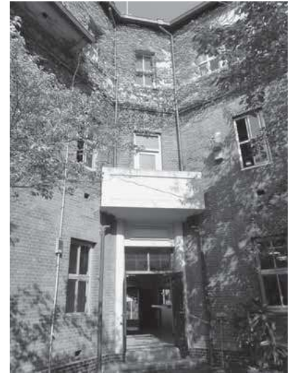
⑪中庭からの入口現状
