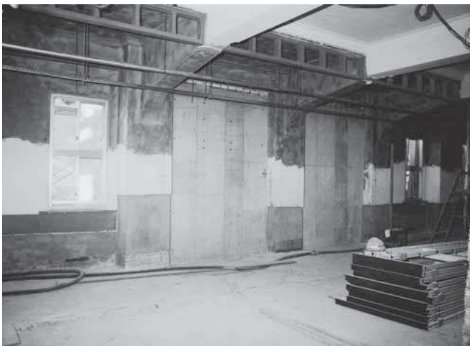
⑭耐震壁（平成7年保存改修）
