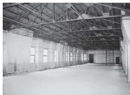
⑰3階小屋トラス（平成7年保存改修）
