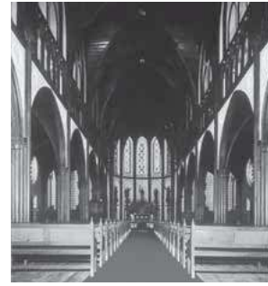
11. 京都 聖ザビエル天主堂 堂内 側廊と内陣の窓は鉄製で、その格子にはめたステンドグラスの屋外側に白色塗料で唐草を描き、その外側に透明ガラスをはめて唐草文様を保護する。
