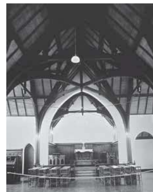
14. 京都 聖ヨハネ教会堂 内部 堂内は幅の広い身廊の両側に狭い廊下状の側廊がある広間式教会堂で、割竹製の化粧野地板を、樫と母屋を経由して洋式トラスが支持する。
