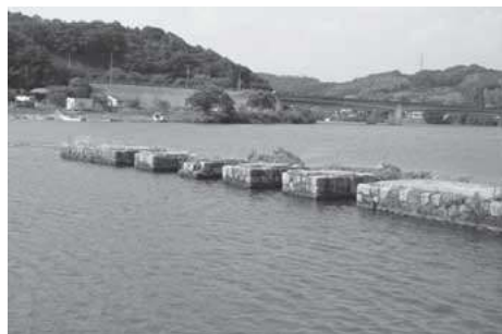
人造石の明治用水旧頭首工
