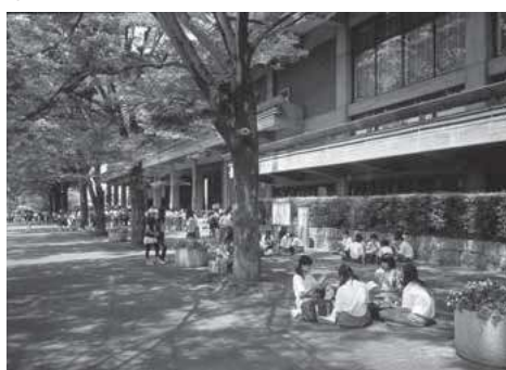
⑯南側道路から見る外観の現況
