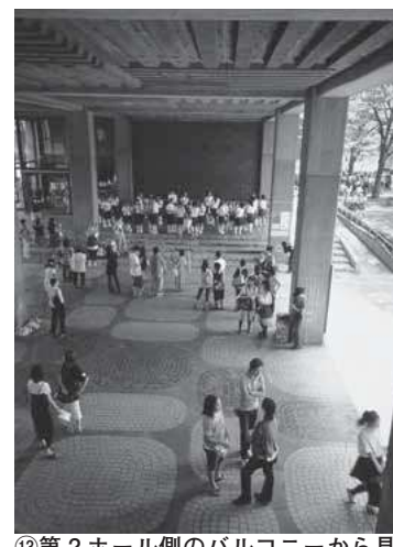
⑬第2ホール側のバルコニーから見るピロティの現況
