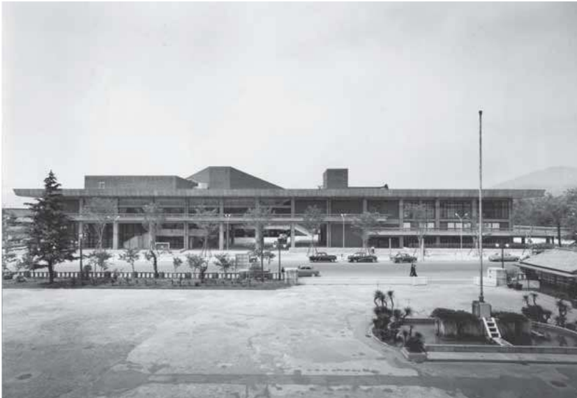
①竣工時の南側から見る全景
