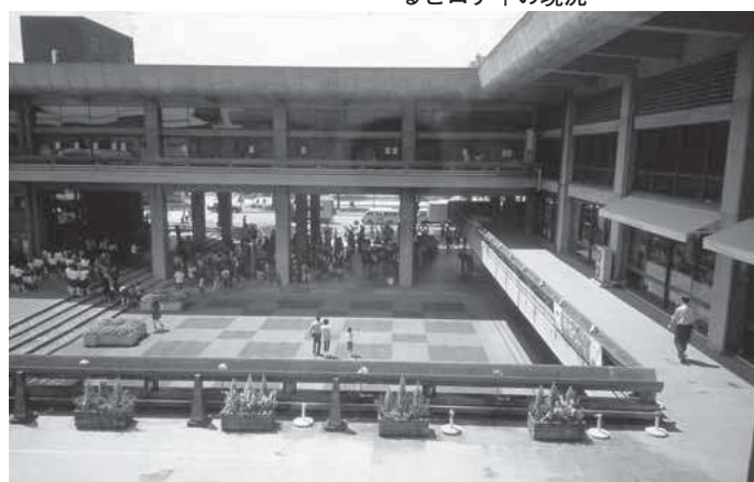
⑮第1ホールロビーから見る中庭の現況
