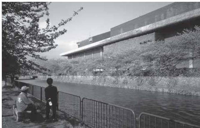
⑨疎水沿いから見る西側外観の現況
