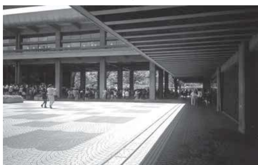
⑰第1ホール前の中庭から見るアプローチの現況
