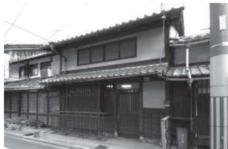
改修前のファサード。出格子や駒寄せが残っている
