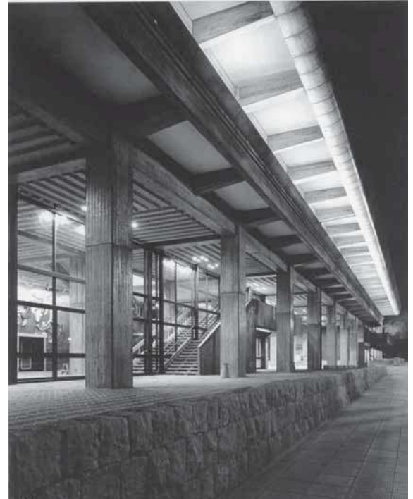
④竣工時の南側外観夜景
