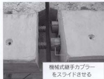
図2 PCa工法 —梁の接合部（スライド型）—
