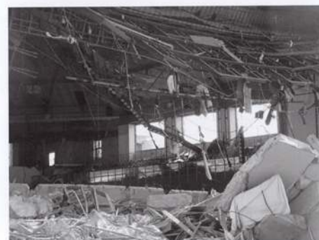
図2 指定避難所の陸前高田市民体育館も天井付近まで津波が突き抜けた (2011年5月15日撮影)
