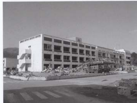
図1 陸前高田市役所は津波が最上階まで突き抜けた (2011年5月15日撮影)
