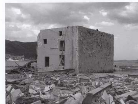
図4 宮城県女川町ではRC造の建物が津波の圧力で横転し流されていた (2011年5月14日撮影)
