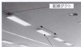
配線ダクト用照明器具 (取り外し及び矢印方向に移動可能)
