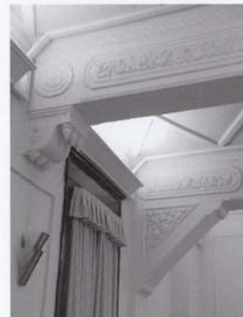
㉑ 4階ホールのハンチ
