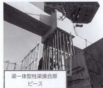
図1 PCa工法 —施工方法は順串刺工法—
