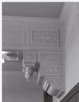
⑱ 3階1号室のハンチ
