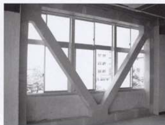
(c) 型枠脱型・仕上げ
