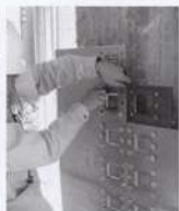
(a) 鋼製パネルの取り付け、組み立て
