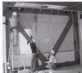
(a) 棒鋼管、ブレース鋼管の取り付け
