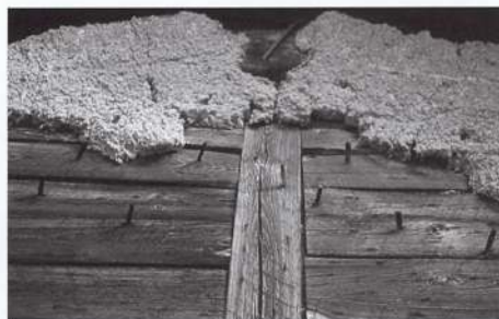
同細部 厚板の全面に堅木のくさびを打ち込み、そこから縄を垂らして土を塗り込む
