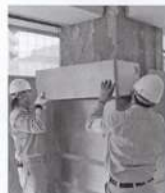
(a) 鋼製パネルの取り付け、組み立て
