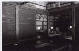
同オモテ(客間)の壁だけに落とし板壁で、それ以前の古い壁構法を留めている。
