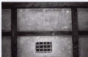
同内部 貫構造に土塗り壁の技術開発が民家を成立させた。壁には大量の稲藁がスサとして練り混ぜてある。
