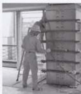
(b) モルタル注入
