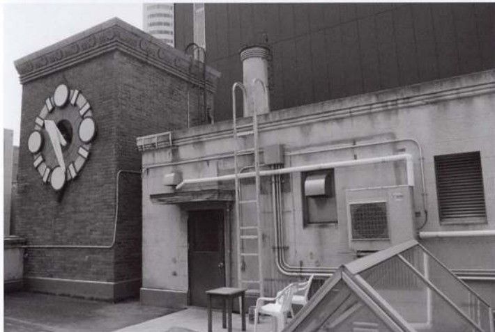
⑪ 屋上の時計塔 (左) と階段室、平成14年に新設されたトップライト
