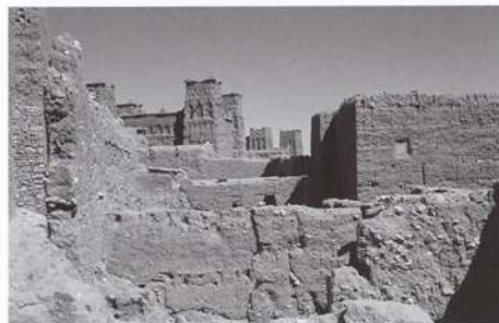
写真2：地面近くで厚さ1mにもなる土壁は、あるものは今も立派に四周の塔を支え、あるものは風化して溶けて土に戻っていく。
