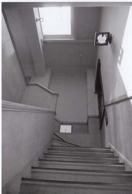
⑬ 4階から5階へ至る主階段 天窗の新設により大変明るい
