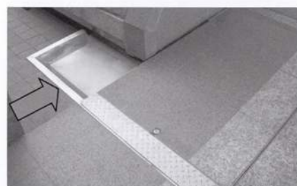
写真3 JFE443CT適用例 (免震エキスパンション)
