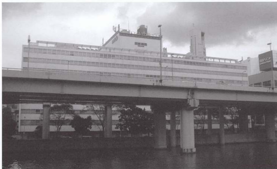
①外観 1960年代半ばに開通した阪神高速環状線の高架橋が正面を塞いでしまった。（平成18年11月撮影：笠原一人）
