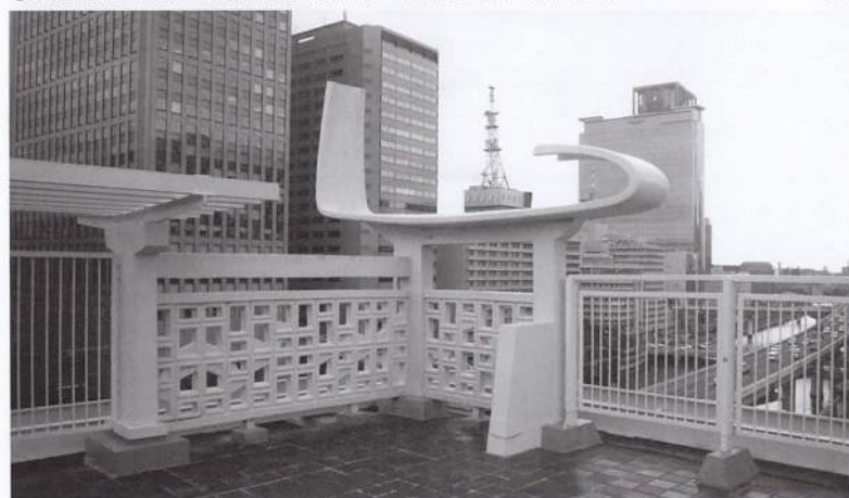
⑫屋上の両端部に設置された装飾
