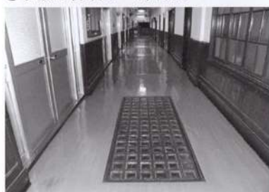
⑦1階廊下と地下室明かり取り用ガラスブロック（現在）
