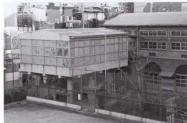
⑧増築部分 幼稚園2階室内プール・体育室（現在）
