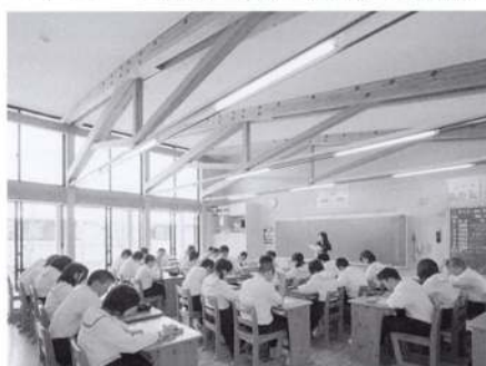
写真1 製材とテンションロッドによる普通教室棟のトラス屋根
