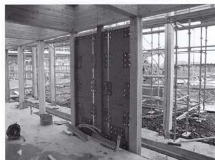
写真2 鋼板耐震壁
