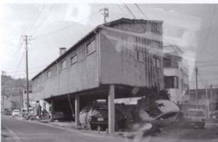
多く残るピロティ型の建築物 (石巻市)
