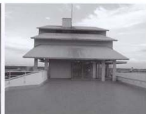
⑯屋上塔屋
