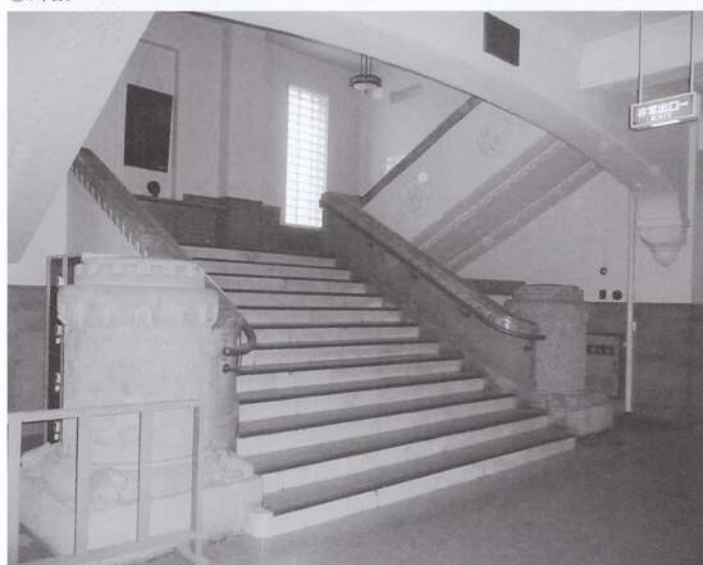
⑫ 1階中央階段室付近
