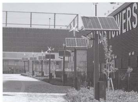
写真6 アリオ橋本 外構 太陽光・風力外灯
