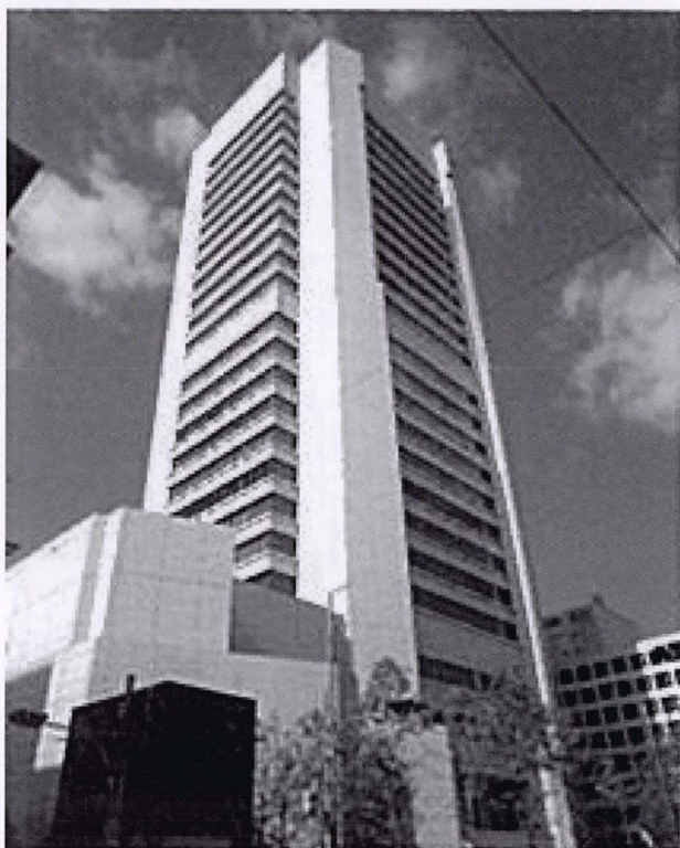
大和（現：りそな）銀行本店ビル PCCW 本石（御影石）打込み仕上げ。
