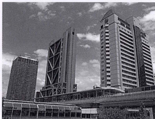
P&G 日本本社ビル PCCW フッ素樹脂塗装仕上げ (SFRC)。 ホテル六甲ベイシェラトン&タワーズ PCCW タイル打込み仕上げ。 イーストコート 3 番街 PCCW タイル打込み仕上げ。
