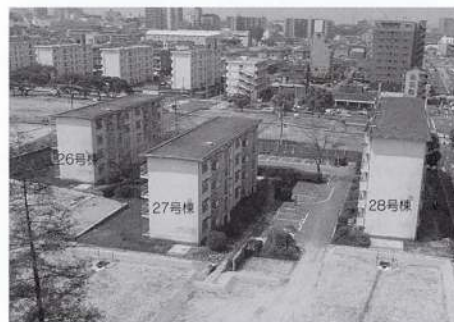
図1 実証試験の現場となった向ヶ丘第一団地
