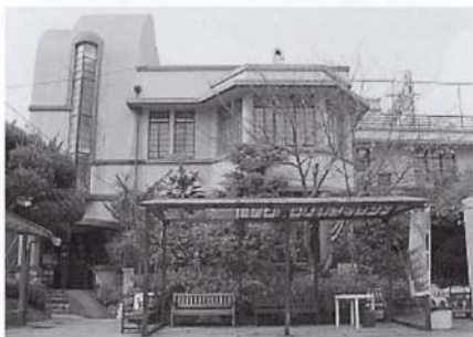
【旧高嶋家住宅／神戸市東灘区】
