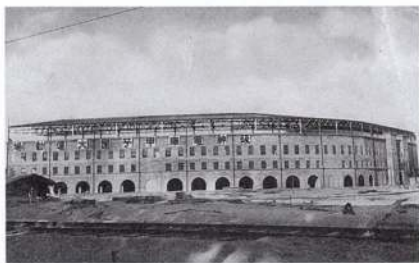
甲子園球場 (大正13年) 写真提供: 阪神電鉄㈱ 当初設計・施工/大林組 改修設計・施工/大林組
