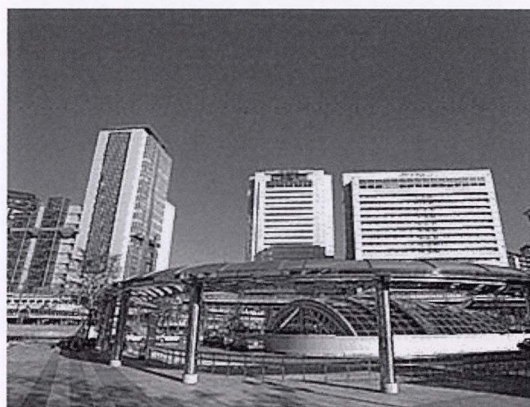
オーガスタプラザ PCCW タイル打込み仕上げ。
