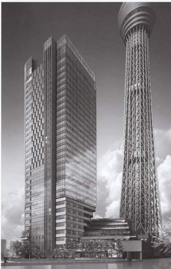
業平橋押上地区街区開発
