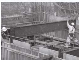
鉄骨小梁取付状況
