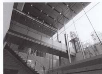
エントランスカーテンウォールとブリッジ (C)
