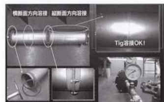
写真3 生産機器排気のダクト様改善
