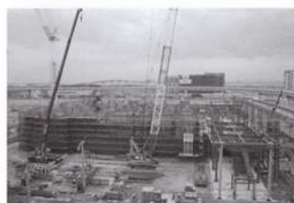
3階躯体施工時
