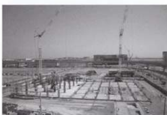
1階躯体施工時
