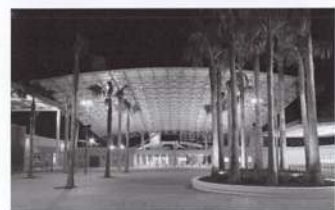
図2 立体トラス大屋根竣工
