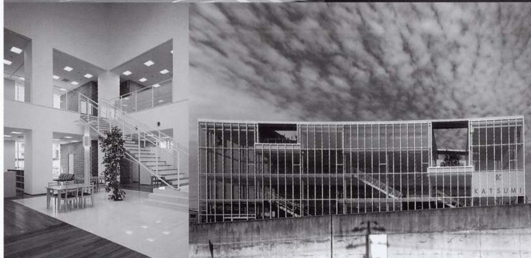
左上（改修後 小写真改修前）・左下：加古川店 右上・右下：神戸店
