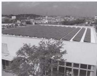
写真3 中部工場食堂棟 (太陽光発電システム30kW)
