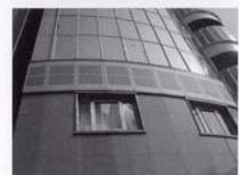
図5 アルボリックベース壁材一体型太陽電池施工例
