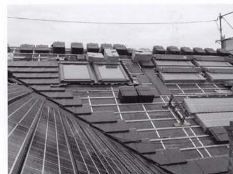
屋根材一体型モジュールの施工
