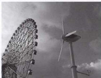
写真2 りんくうプレジャータウン「シークル」 (小型風力発電機10kW)
