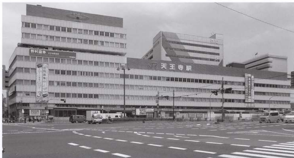
①北西側外観（現在） 2003年に外装を一新して、色調も白へと様変わりした
