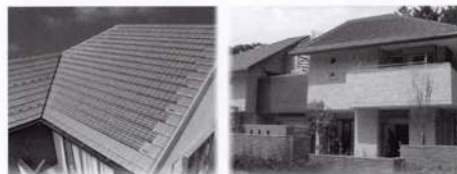
図4 平板瓦用屋根材型太陽電池「HEYBAN」
