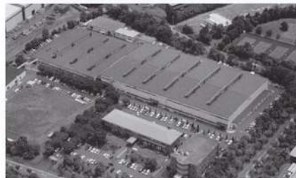
写真2 工場屋根塗装事例
