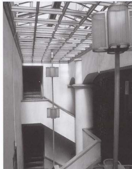
⑧階段吹き抜け（1991年頃）
