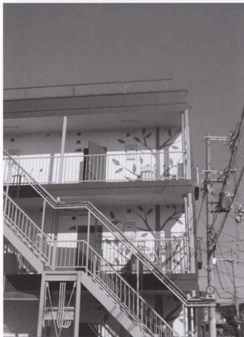
西淀川集合住宅 改修後
