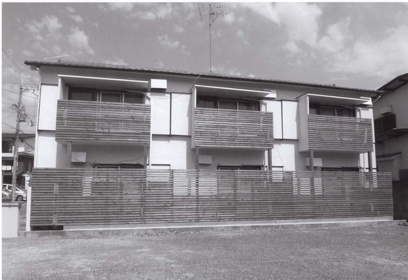
北伊丹集合住宅 改修後
