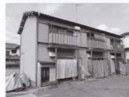
北伊丹集合住宅 改修前
