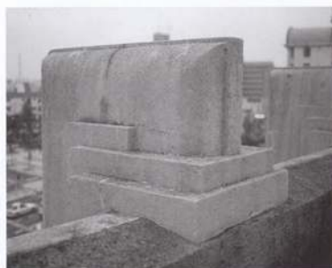
⑩屋上から見たファサード装飾（1991年頃）
