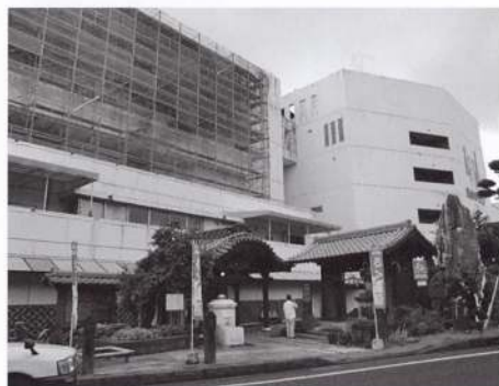
山鹿温泉の再建。山鹿市は重要文化財の八千代座で知られる。山鹿温泉の建物はかつては道後温泉のような木造建築であった（模型を参照）。これを昭和40年代の再開発で鉄筋コンクリート造の商業ビルの一部にしてしまった。今回、歴史まちづくり法の国庫補助により、既存の再開発ビルは取り壊し、商業ビルを建て替え、公共温泉の建物は木造で復原・再建する。
