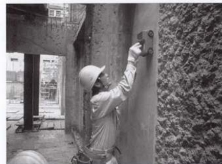
既存躯体調査
