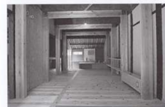
耐震改修後の室内
