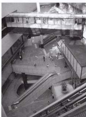
工事中のウェルカムロビー
