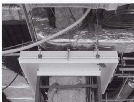
図-1 梁と照明ボックスの隙間を通るダクト
