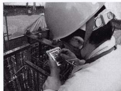
写真1 PDAによる検査の状況
