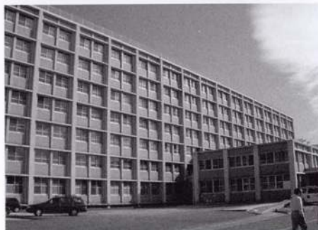
改修前の南外観
