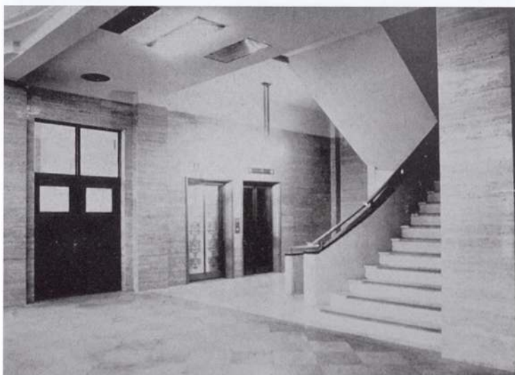
③階段とエレベーター 元は玄関ホールであったが、現在は玄関の位置が移動している。この角度からは階段のカーブが分かりづらく、エレベーター扉の意匠も見えない。
