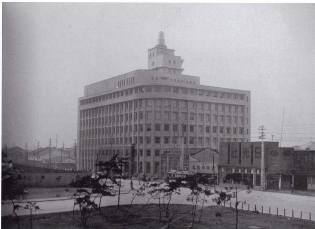
②京都駅から見た南東側外観 柱梁で組まれた格子状の意匠が際立つ。
