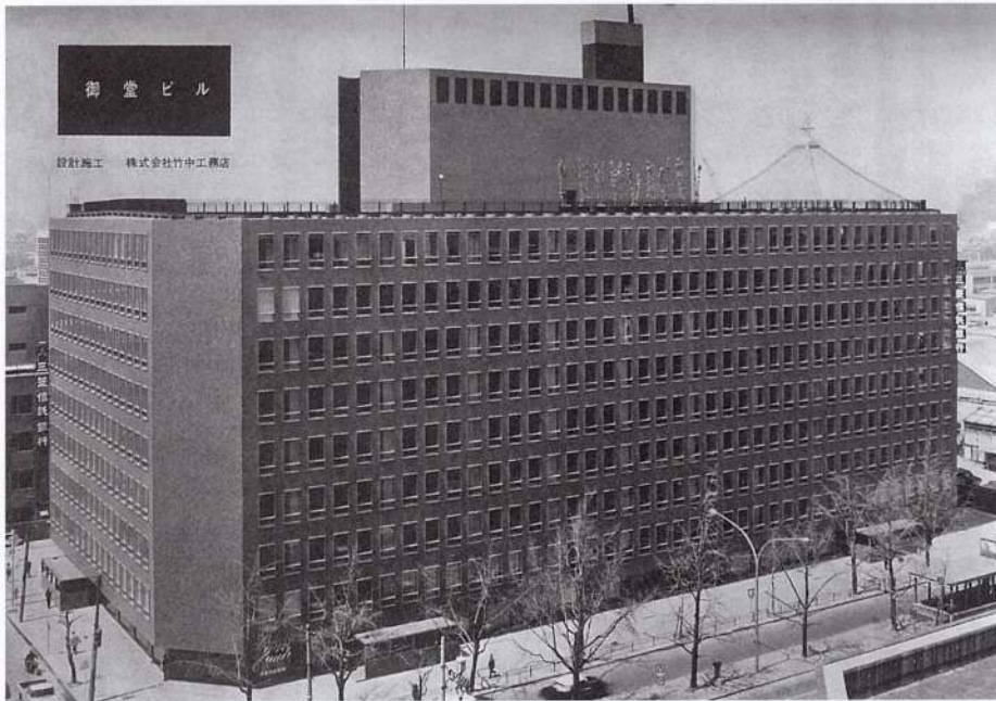
②御堂筋側の外観
