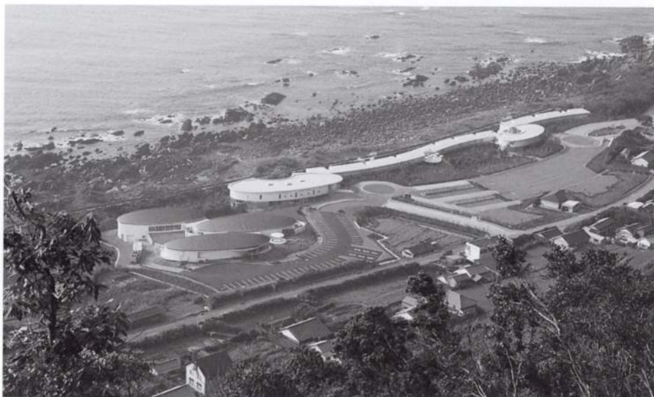
バーデハウス室戸鳥瞰 手前の3つの楕円の建物が バーデハウス室戸
