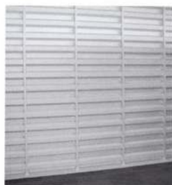
写真1 波形鋼板耐震壁
